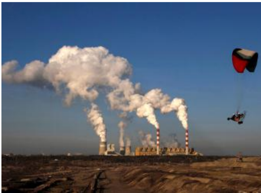
↑ Når Polen produserer kull, må de kjøpe utslippkvoter fra andre produsenter, og disse må da redusere sine utslipp med tilsvarende mengde. Dette er dyrt og øker energiprisen, noe som i sin tur gjør det lønnsomt å bygge ut fjell og fosser selv uten opprinnelsessertifikater. Her fra Belchatów kullkraftverk. Foto: Kacper Pempel/Reuters/NTB Scanpix
